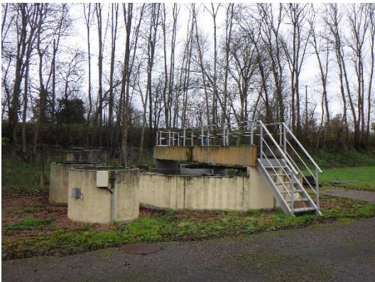
Entretien et fonctionnement satisfaisants, génie civil vieillissant (fuites sur l'ouvrage de réception des effluents) mais ne remettant pas en cause l'état structurel des ouvrages
