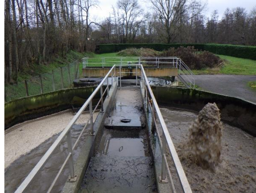
Entretien et fonctionnement satisfaisants, génie civil vieillissant (fuites sur l'ouvrage de réception des effluents) mais ne remettant pas en cause l'état structurel des ouvrages
