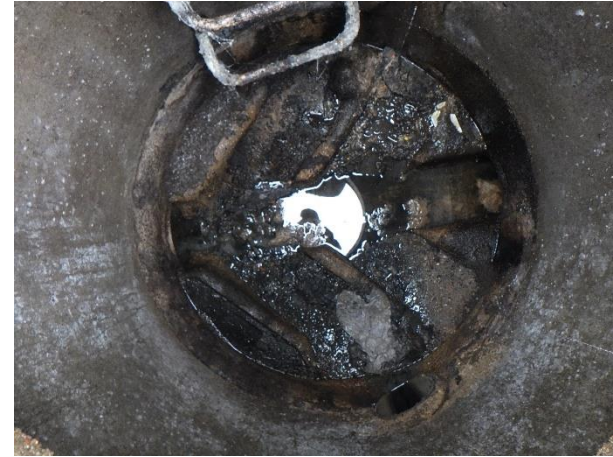
Écoulement difficile – Impasse Pensemolle
