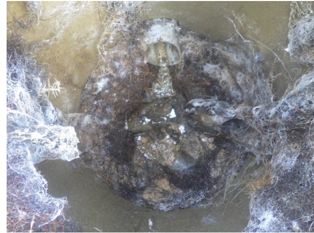
Racines et infiltrations - RV 769 – Chemin des Gatilles
