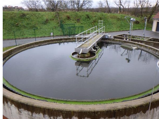
Présence significative de lentilles d'eau dans le clarificateur signalée en été
